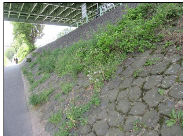
Abbildung 6: Linkes Rheinufer – Uferbefestigung
