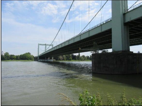
Abbildung 7: Rodenkirchener Brücke – westlicher Stützpfeiler
