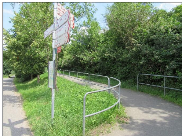
Abbildung 12: Böschungsbereich am Radweg zur Rodenkirchener Brücke
