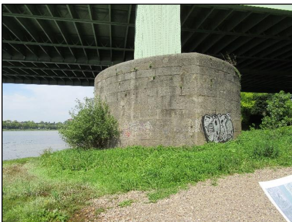
Abbildung 9: Rodenkirchener Brücke – östlicher Stützpfeiler
